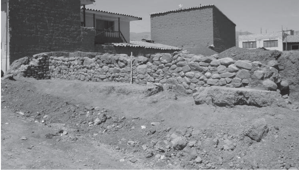
Figura 10. Estructura rectangular recuperada la cual fue tapada con tierra.
