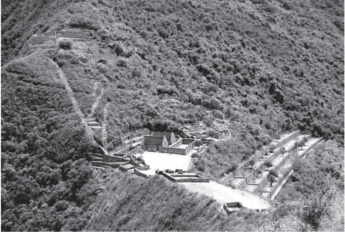
Figura 4. Vista general del sector principal de Choquequirao.
