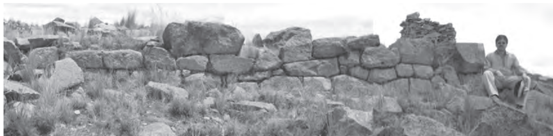
Figura 7. Estructuras de piedra de Inkaperqa.
