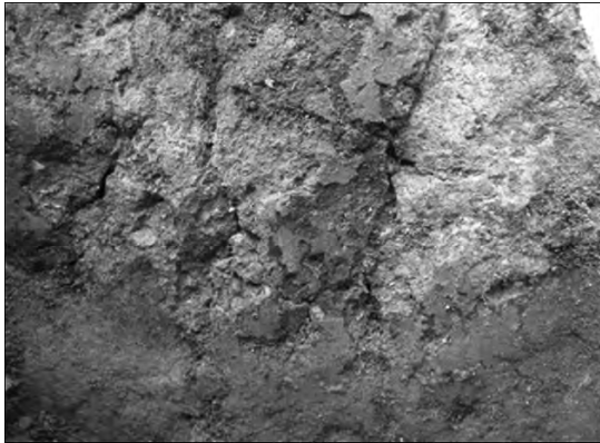
Figura 14: Restos de pintura de color blanco y Marrón hallados en el muro de adobes.
