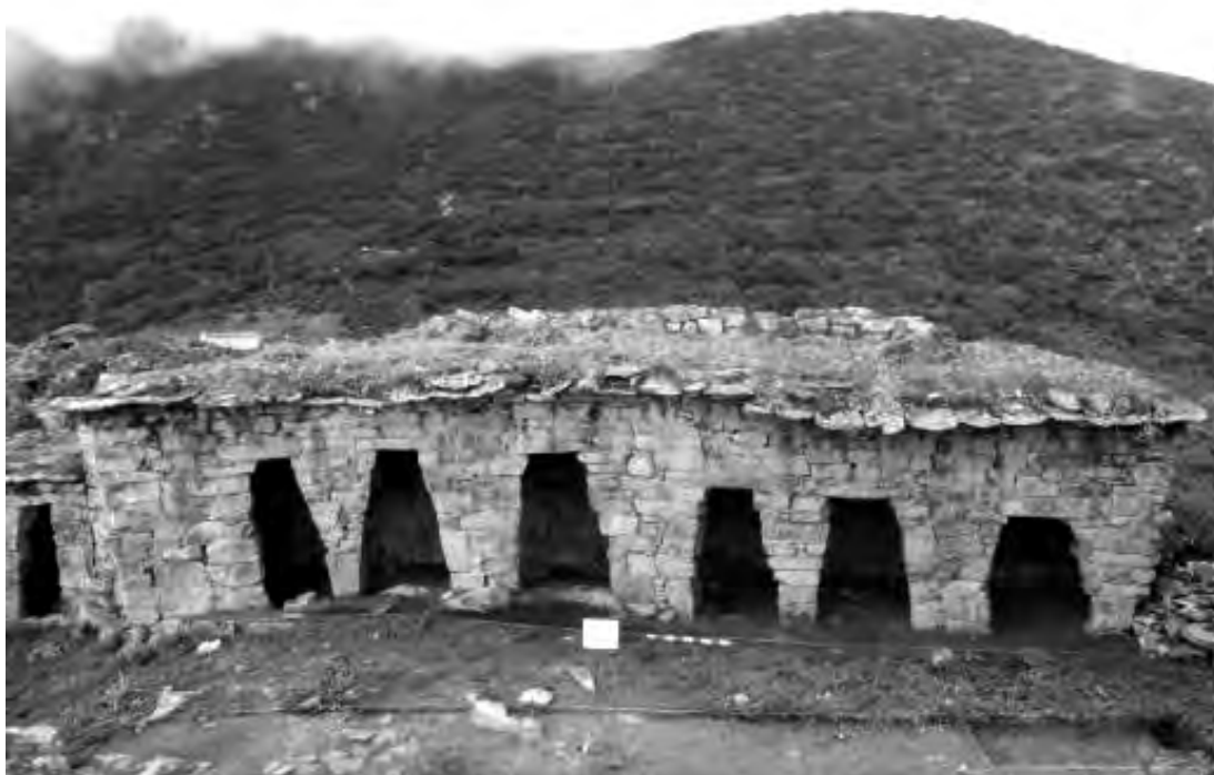
Figura 16: Vista general del edificio 1, unidad 3.
