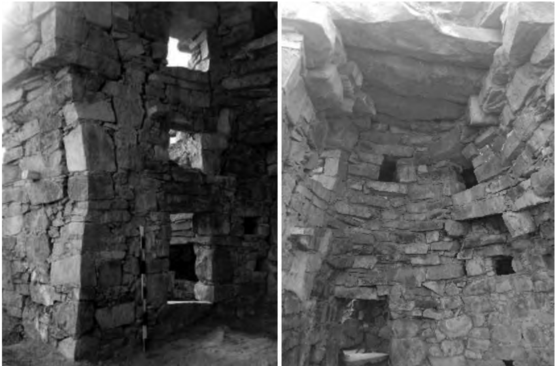
Figuras 26 y 27: A la izquierda vista panorámica de los tres niveles de cámaras, ubicados hacia el lado sureste del Recinto N° 01. A la derecha interior del edificio
