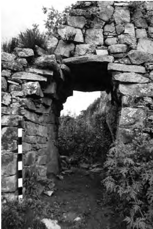
Figura 4: Vista del vano de acceso ubicado al oeste de la muralla sur.
