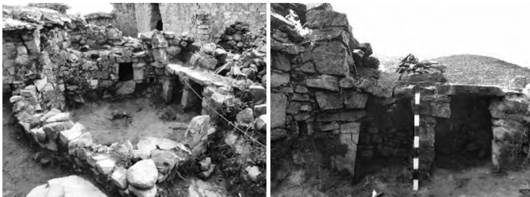
Figuras 33 y 34: A la izquierda recinto N° 1. A la derecha: inferior derecha cámara N° 04, inferior izquierdo cámara N° 05 y superior cámara N° 06.
