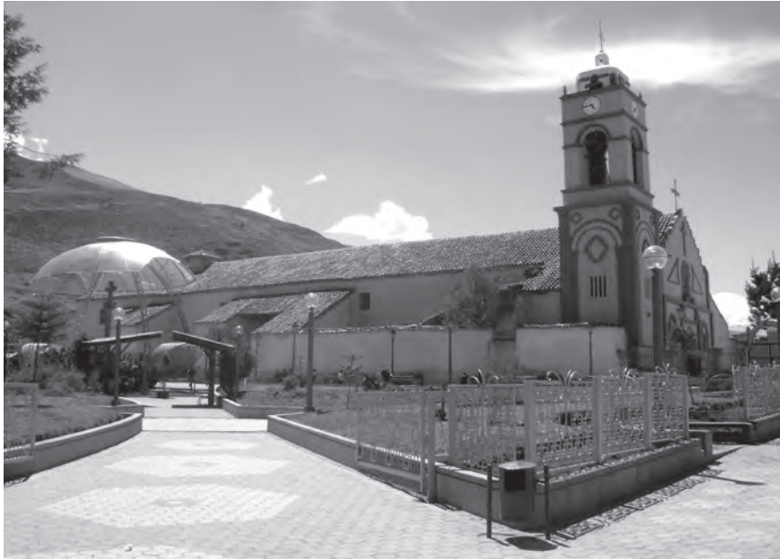
Figura 2. Vista general de una parte de la plaza y la iglesia principal del pueblo de Chongos Bajo desde el sureste. Hacia la izquierda se observa una estructura de metal con cubiertas de acrílico en la que se encuentra la escultura de Cani Cruz (Foto: M. Perales 2010).
