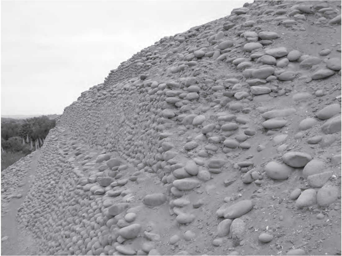
Figura 5. Muros de contención del lado este de la Plataforma del lado este de la Plaza 1.
