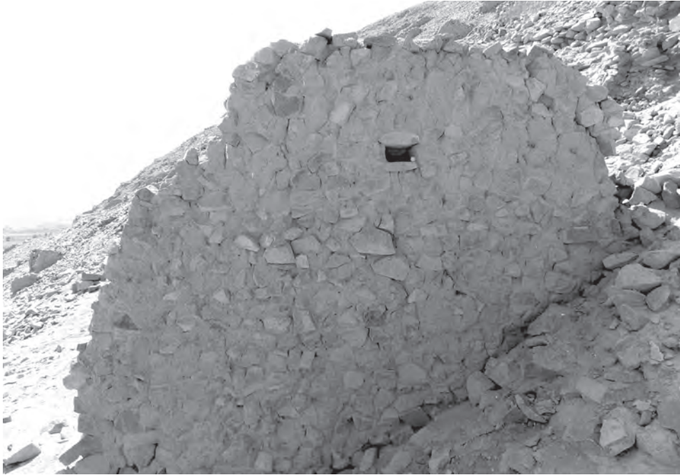
Figura 19: Estructura de Sahuacarí manteniendo más de tres metros de altura.
