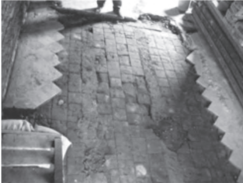
Figura 2. Piso de baldosas coloniales en el primer salón al ser descubierto en 2005, se ve aun restos del piso superior y las roturas para pasar cañerías (foto gentileza D. Fernández).
