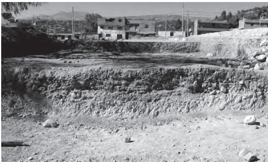
Figura 13. Vista del perfil 7 lado norte de la plaza.
