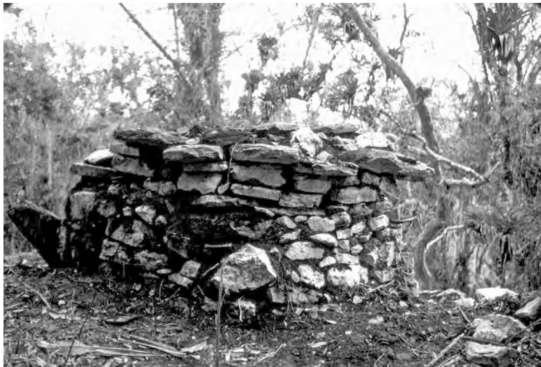
Figura 3. Chullpa de menores dimensiones, localizada al borde de Pueblo Alto de la Fortaleza de Kuelap. Tiene planta circular y conserva los aleros y parte del techo para lo que utilizaron lajas de piedra. (Fotografía: A. Ruíz E.)
