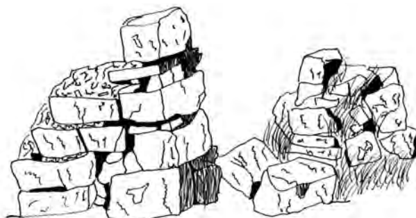
Figura 4. Detalle de la construcción del acceso a una estructura rectangular Huamani, Huangáscar.
