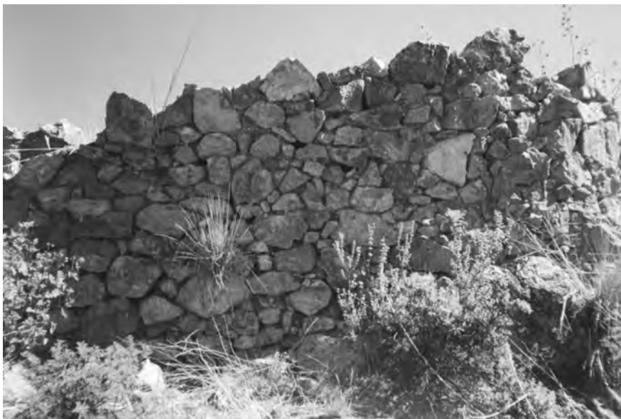
Fotografía 5. Muro de contención, Sector II del sitio de Pucahuasi, Huangáscar.
