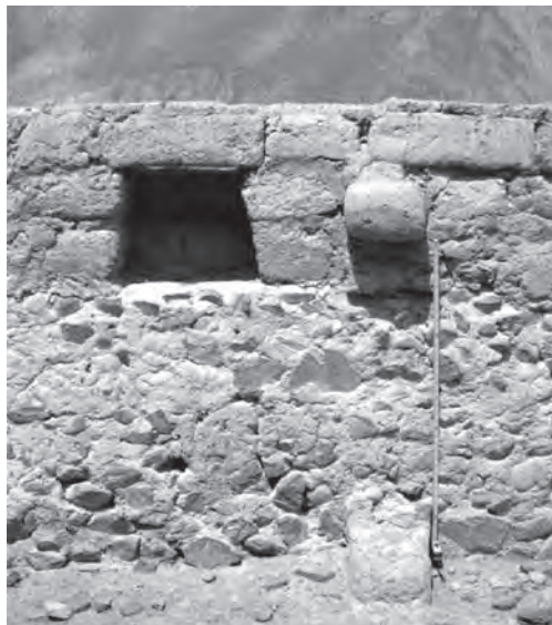
Figura 16: Detalle constructivo y decorativo de un muro Tawantinsuyu en el sitio de Antahuaya I.
