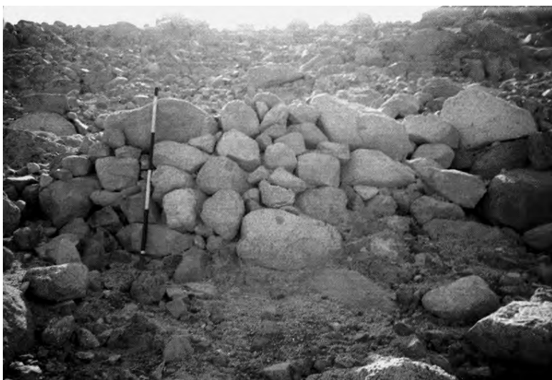
Figura 6: Cuesta Blanca. Muro de contención ubicado al suroeste del sitio.
