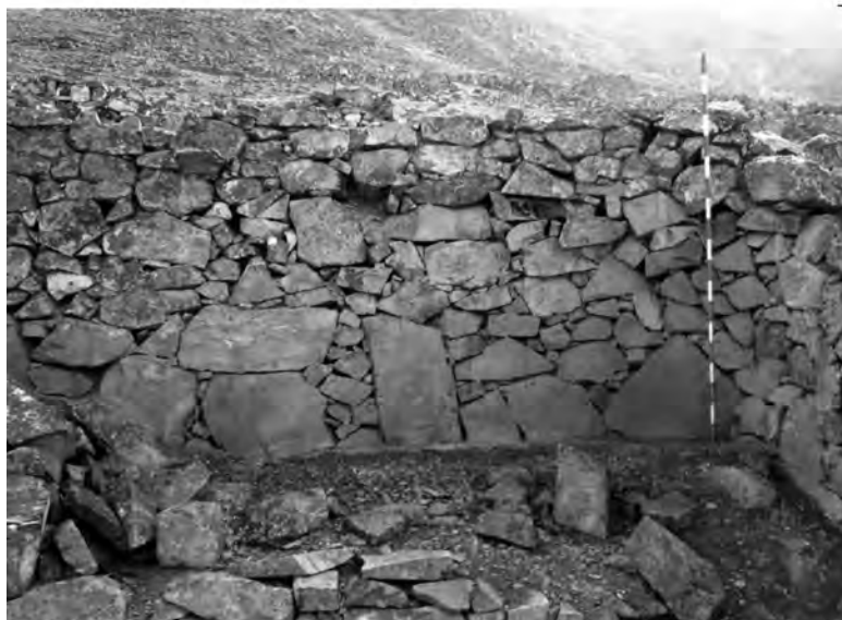
Figura 16. Arriba: Vista de muro exterior de uno de los recintos en Caringa. Abajo: Detalle de la técnica constructiva.
