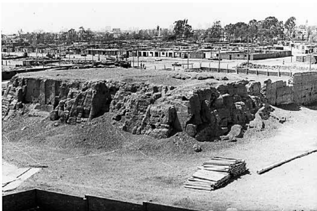
Foto 1: El monumento San Borja Norte destacando su planta y elevación en cuadro antes de comenzar los trabajos. El edificio se muestra limpio y despejado de los escombros y basura que lo cubría con anterioridad.
