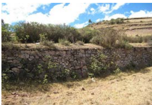
Figura 28 .Camino con corte de talud y muro de retención
