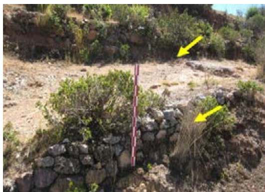
Figura 29 . Camino con corte de talud y muro de contención y retención
