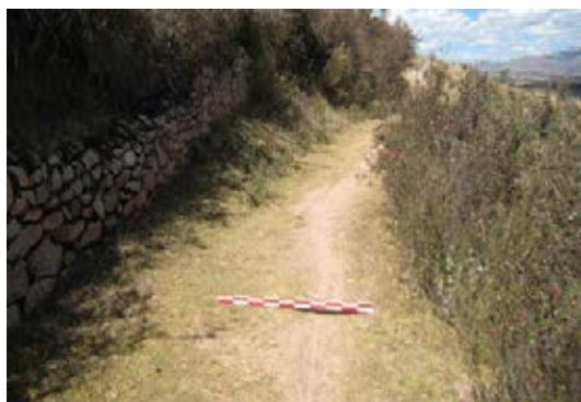
Figura 27. Camino con corte de talud y muro de contención
