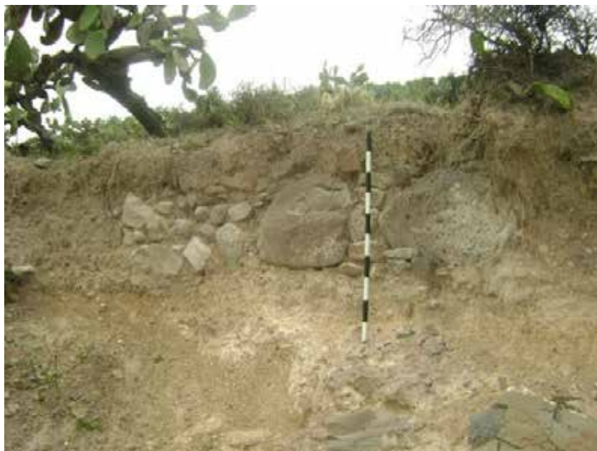
Figura 22. Muros de contención de terrazas agrícolas del formativo Superior
