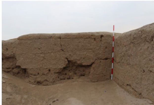
Figura 28. Muro de abodones, Subsector Tello.
