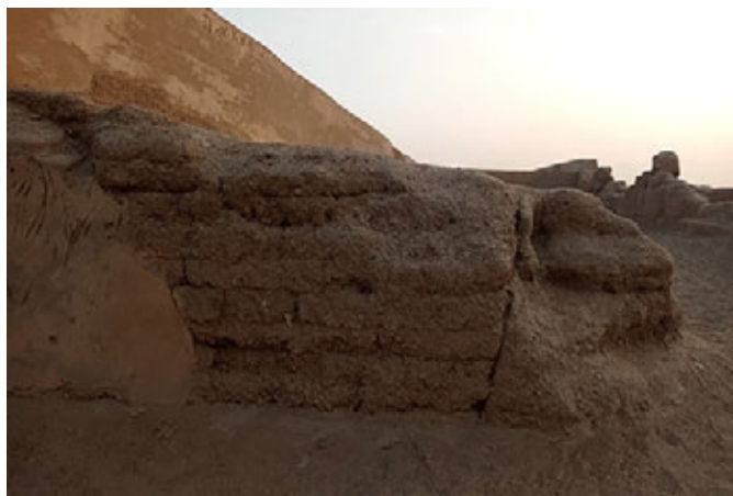
Figura 04. Técnica constructiva de abodes, en muro de sector Laberinto.
