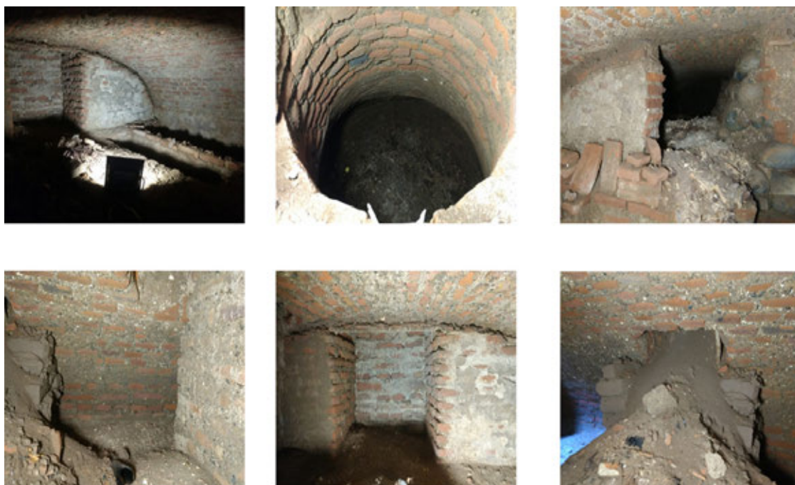
Figura 16. Características arquitectónicas de la bóveda sepulcral.
