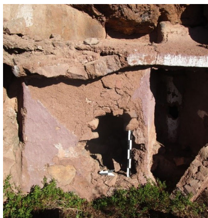
Figura 25. Cubierta de forma irregular, E.F-N°4 del sector "I".
