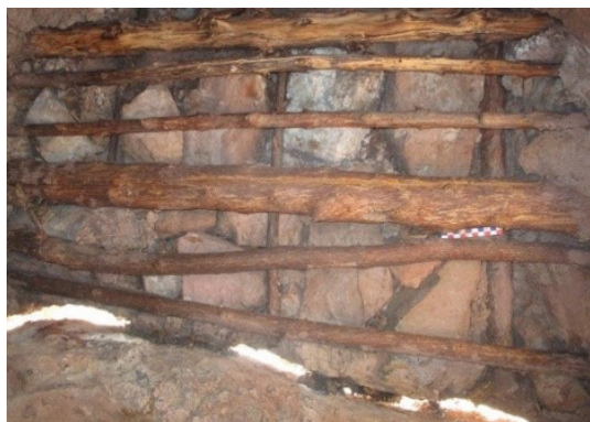
Figura 29. Cubiertas con rollizos de Qishuar puestas cruzadas una sobre otras, E.F-N°20 del sector "I".
