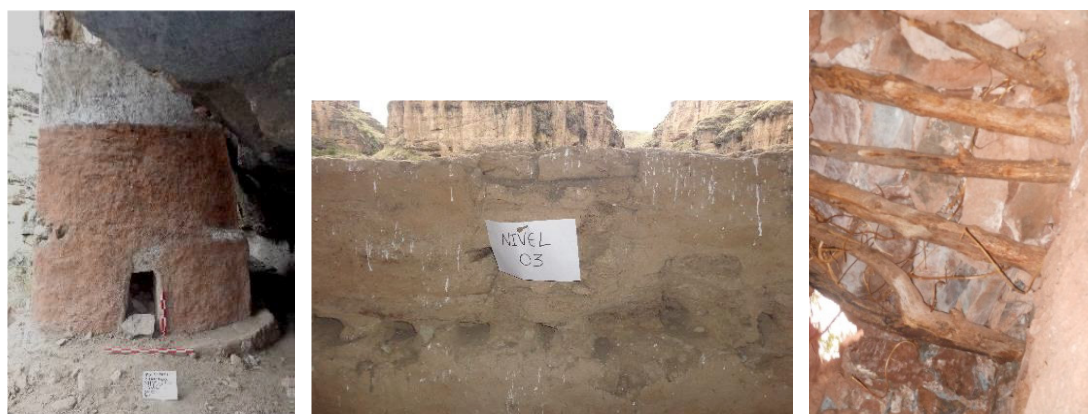
Figura 4. A) y B) Evidencia de agujeros con resto de palos en el segundo y tercer nivel del abrigo N°46 en el sitio de Ch'íñisiri (Sumiré, 2014, pág. 95), C) Rollizos de Quishuar de un diámetro de 2,5 a 3 pulgadas que funcionaron como vigas que soportan la cubierta de lajas, en el sitio de Machuwasi - San Salvador. (Pizarro, 2014, p. 68).
