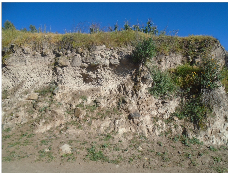
Figura 24. Perfil con restos de estructura.
