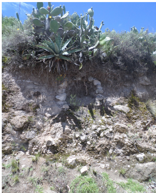
Figura 23. Sección de estructura funeraria alterada por la construcción de la carretera .
