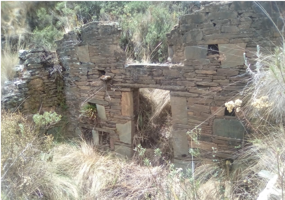
Figura 7: Muro que divide en dos espacios la vivienda “Tipo Rapayán”, de planta rectangular (Sector B). Nótese la técnica constructiva más fina y el uso del lado plano de las piedras para darle un acabado estético al vano de acceso y a los nichos.
