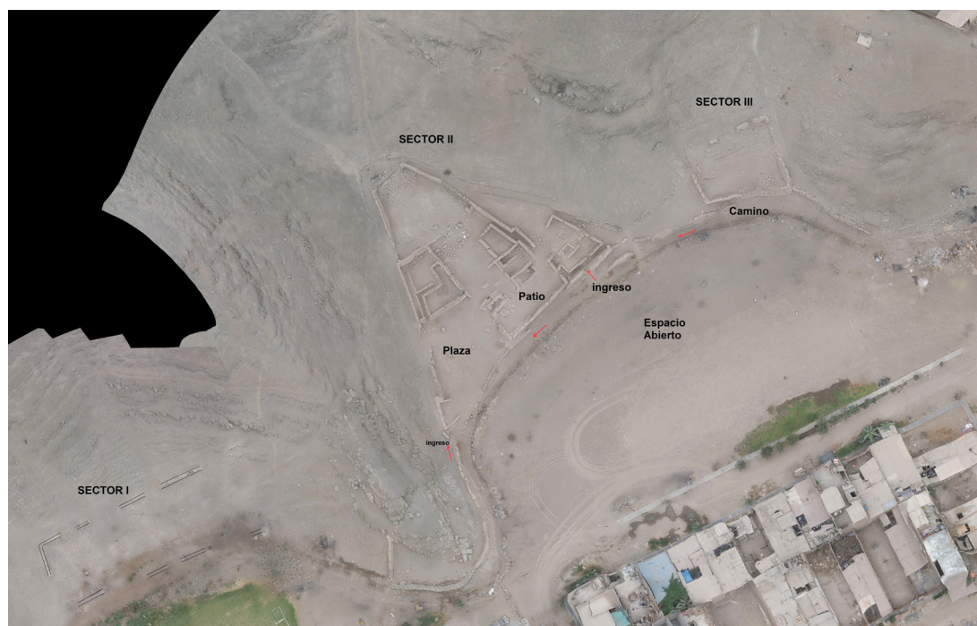
Figura 8. Palacio Oquendo, detalle de los tres sectores, la composición arquitectónica de la residencia de élite asociada al camino inca.
