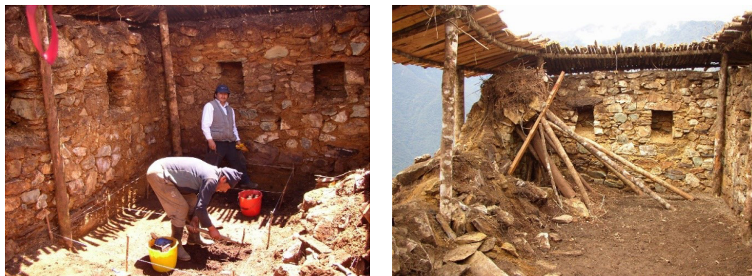
Figura 12. Proceso de excavación y medidas de mitigación para la conservación del santuario (2002).
