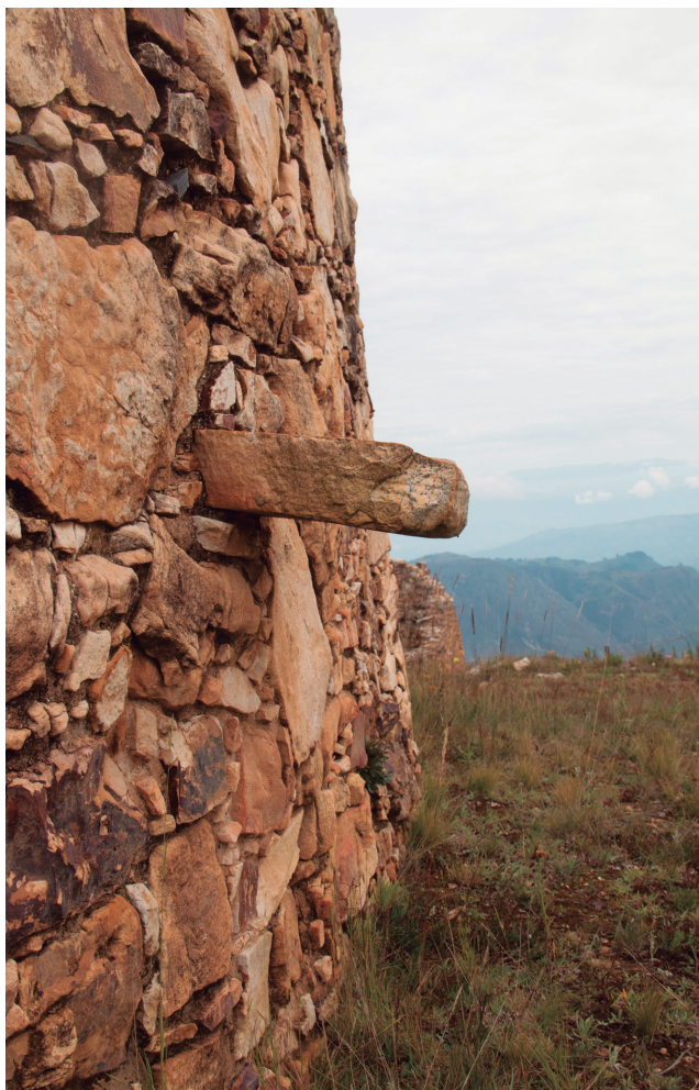
Figura 14. Piedra voladiza en paramento externo del muro perimetral externo del edificio B, ubicada a menos de un metro de un entierro mural (UE007 Marcahuamachuco).
