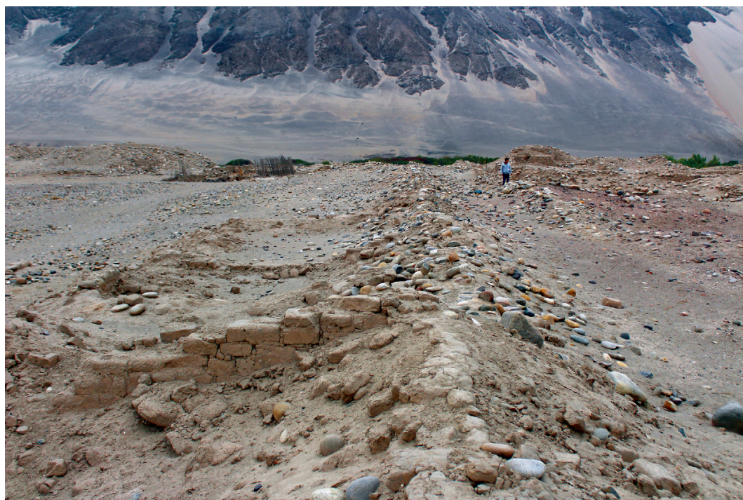
Figura 6. Las destruidas estructuras del sector inka de Tambo Viejo.
