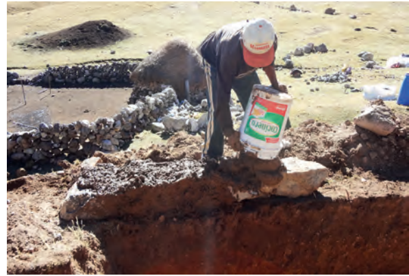
Gráfico 7. Construcción de muro de piedra y barro
