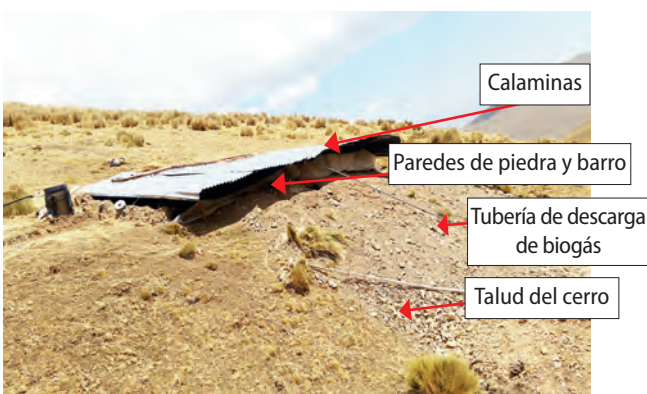
Gráfico 10. Techo de calamina del biodigestor
