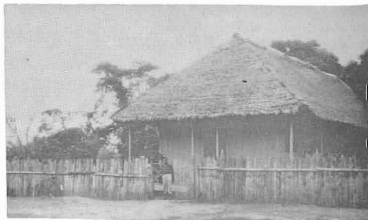
12.- Hospital de Puerto Maldonado.
