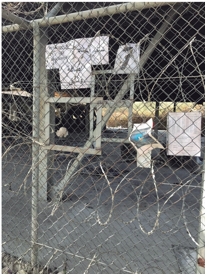
FIGURA 3: Fachada del edificio de oficinas de asilo quemado en el campo de Moria. Hay que tener en cuenta la valla doble (que crea una zona de amortiguamiento entre los migrantes y el personal de la oficina de asilo) y la abertura rectangular para que las personas ingresen su solicitud y otros documentos (foto: Yannis Hamilakis, 4 de octubre del 2020).
