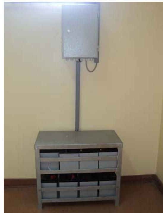
**Fig. 10** Baterías y unidad de control del sistema fotovoltaico tipo 3.
