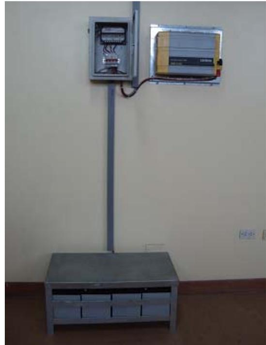
**Fig. 9.** Baterías y unidad de control del sistema fotovoltaico tipo 2.
