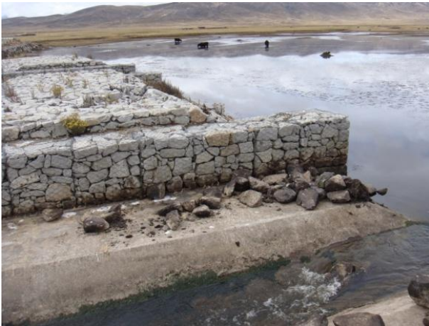
Fig.9. Laguna de Conococha. (a) Tradicional forma de medir el nivel. (b) Muro de contención y control de descarga.
