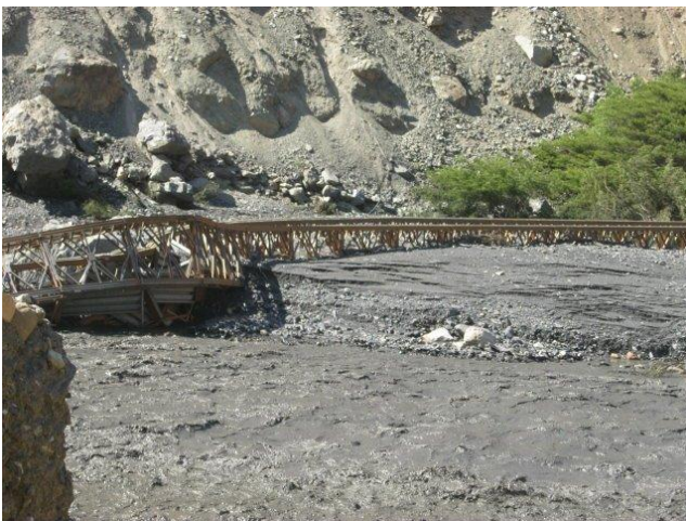
Fig.2. Desborde de la laguna La Encantada. Puente colapsado,[4].
