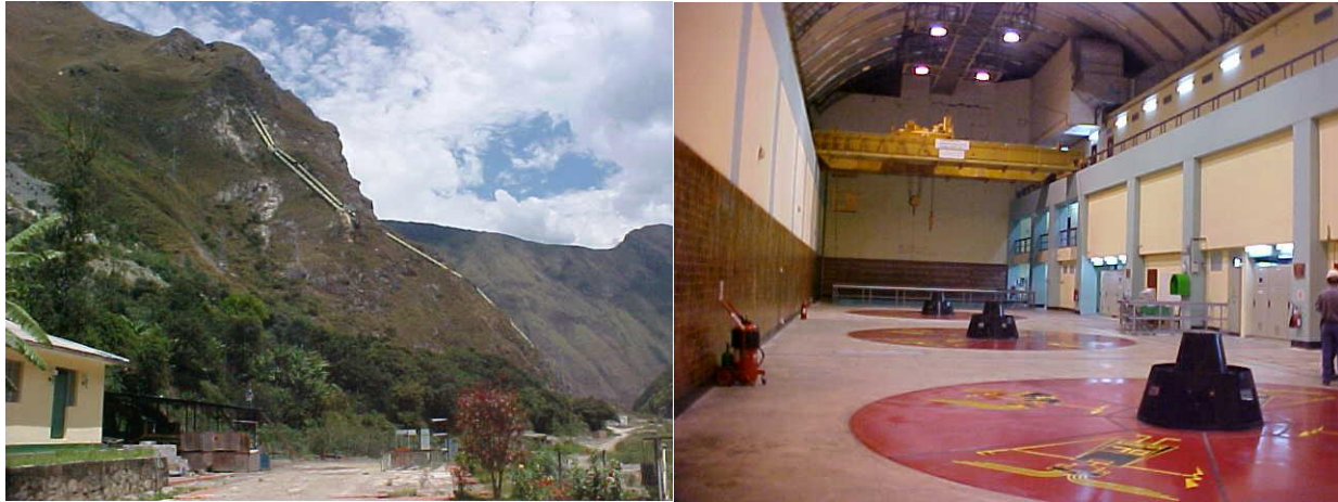
Figura 1: Tubería forzada y sala de máquinas de la 1ra etapa rehabilitación Central Hidroeléctrica Machupicchu. Fuente: EGEMSA, 2012.
