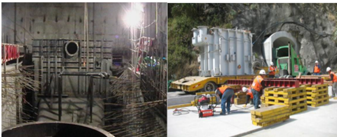
Figura 3: Trabajos de ingreso a la casa de máquinas y vaciado de concreto en la Sub Estación en caverna de la 2da etapa de rehabilitación de la central hidroeléctrica Machupicchu. Fuente: EGEMSA, 2012.
