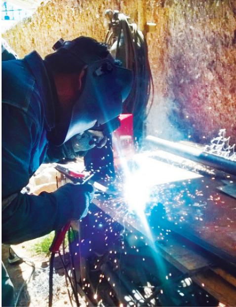
Figura N.º 9. Soldeo en la ciudad de la Oroya, test de soldeo en tubería de 2 pulgadas
