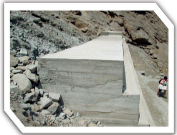
Figuras N° 2. Caja de agua y el parapeto construido parcialmente, aún falta 30 m de longitud.
