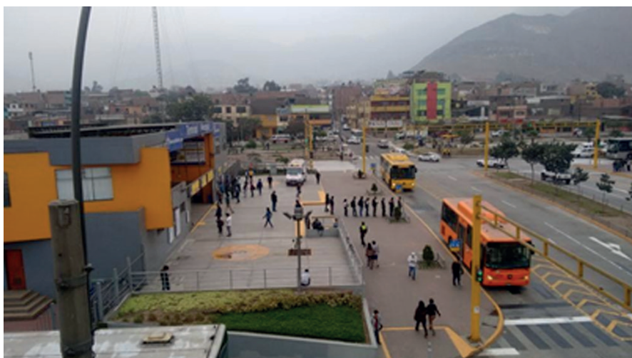
Figura 1. Estación Terminal Norte del Metropolitano en Lima - Naranjal
