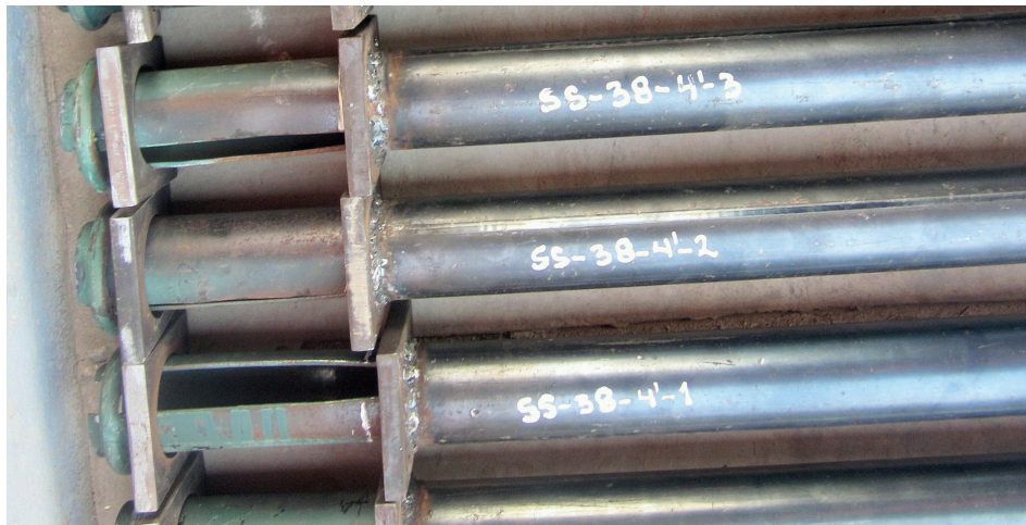
Figura N° 5. Split Sets de 4 pies de longitud efectiva de anclaje ya instalados
