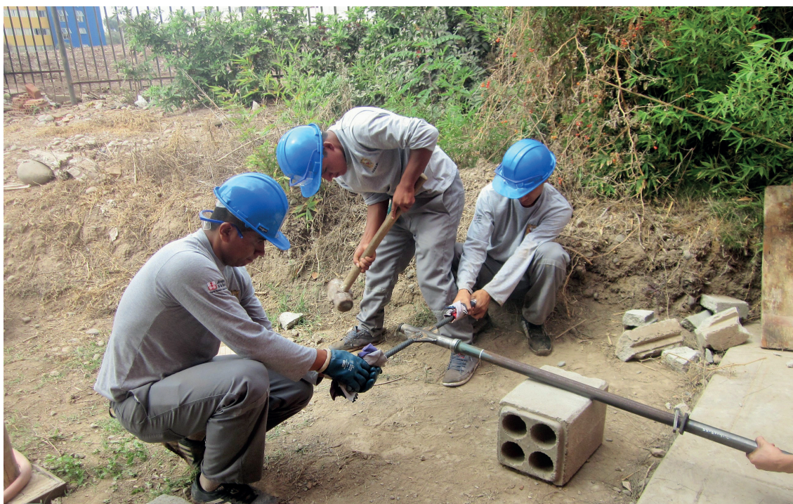
Figura N° 4. Instalación de Split Sets con una cuadrilla de personal con comba
