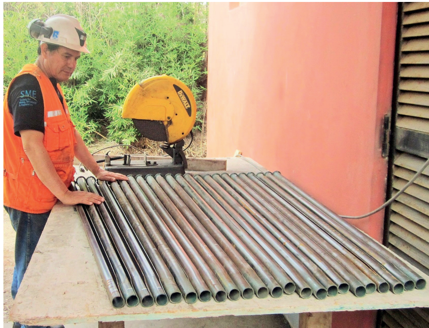
Figura N° 1. Preparación de Split sets, se observa la cortadora Dewalt.
