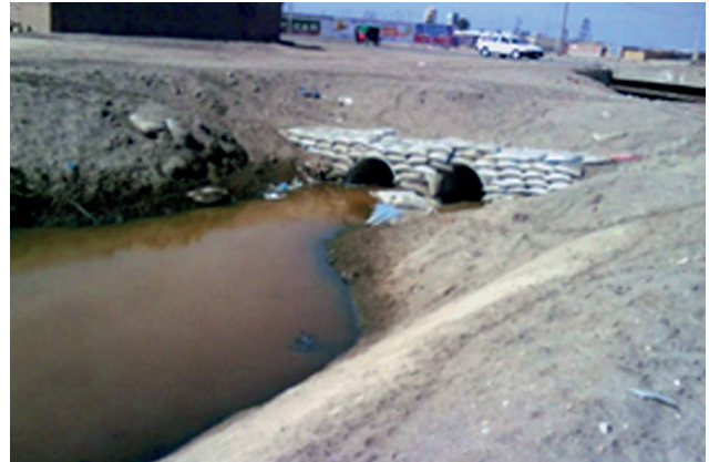
Figura 3. Laguna de Oxidación. Fuente: Propia
