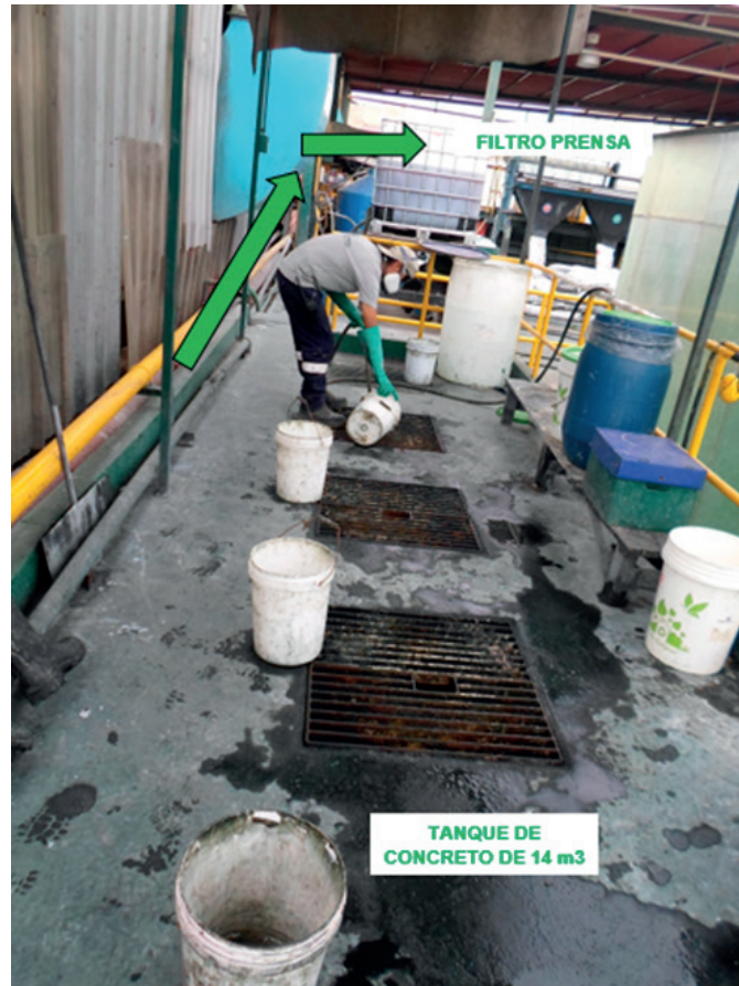
Figura 1. Aplicación de coagulante y floculante en el tanque de concreto. Fuente: Elaboración propia
