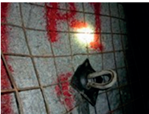
Figura 12. Instalación del perno Durabar
