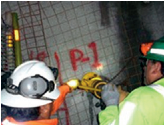
Figura 11. Prueba de Pull Test
