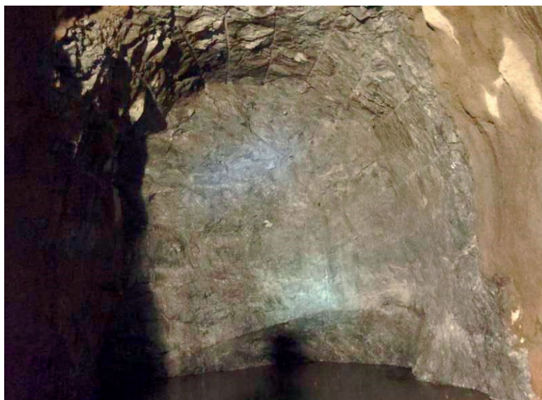
Figura 7. Progresiva 0+951.20. Roca tipo II, avance del frente de 3.1 metros, buen autosostenimiento y alta resistencia a la compresión uniaxial como propiedades de la roca.
