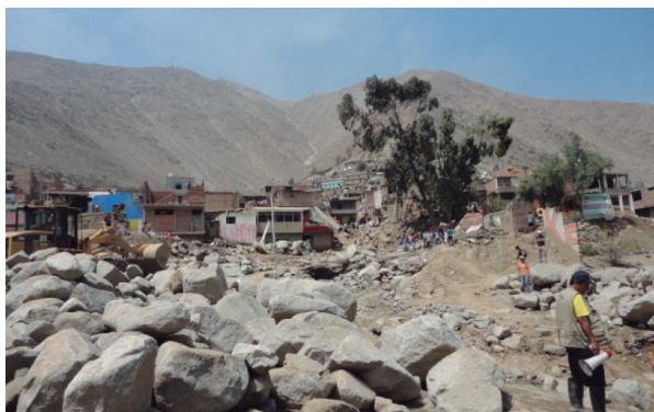
Figura N.º 3: Las rocas subredondeadas y subangulosas producto de la disyunción esferoidal, que han sido transportadas por el huayco y han destruido las viviendas (Mariscal Castilla).
