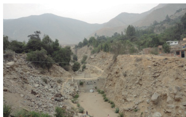
Figura N.º 22: Canal del huayco con diques de contención.
