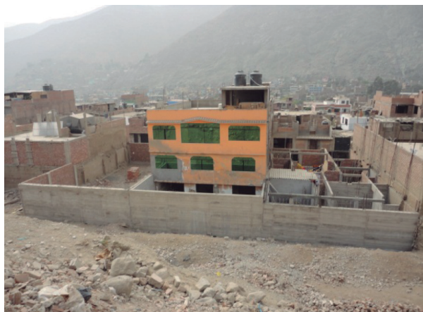
Figura N° 18: Muro de defensa construido luego del huayco que no garantiza seguridad.
