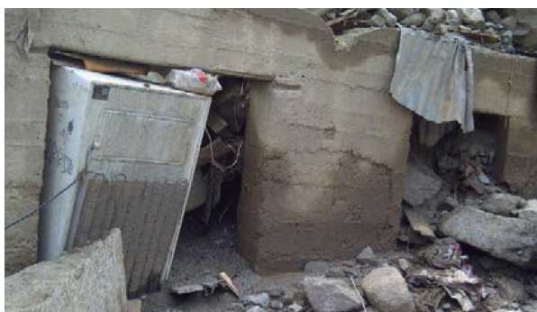
Figura N.º 13: Casa cubierta por los materiales del huayco y enseres fuera de lugar.
