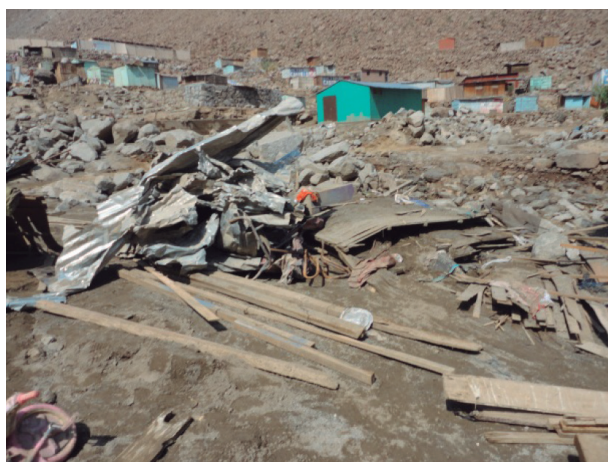
Figura N.º 19: La Ronda (parte alta) modestas viviendas destruidas.
