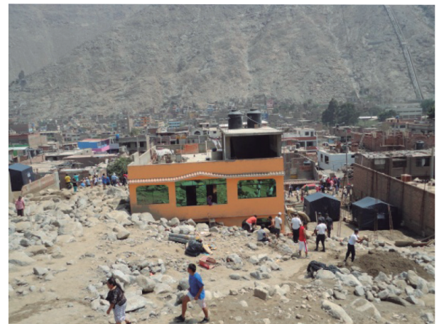
Figura N.º 17: Vivienda enterrada, solo se ve el tercer piso (Cooperativa Pablo Patrón).
