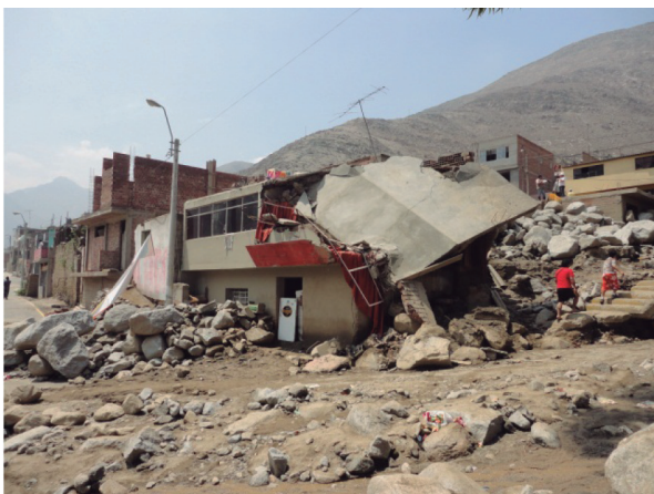
Figuras N.º 14: Sector de Ramón Castilla donde se observa la destrucción de casas.
