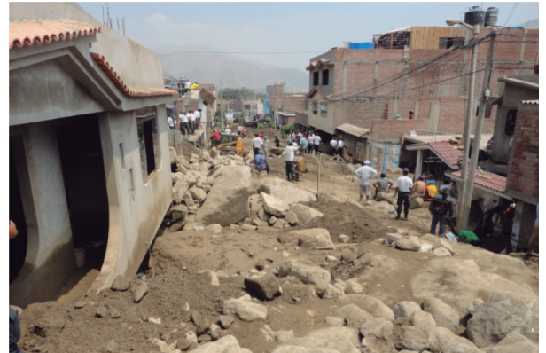
Figura N.º 16: Obsérvese la parte baja de la cooperativa Pablo Patrón invadido por grandes rocas y barro que dejó el huayco.
