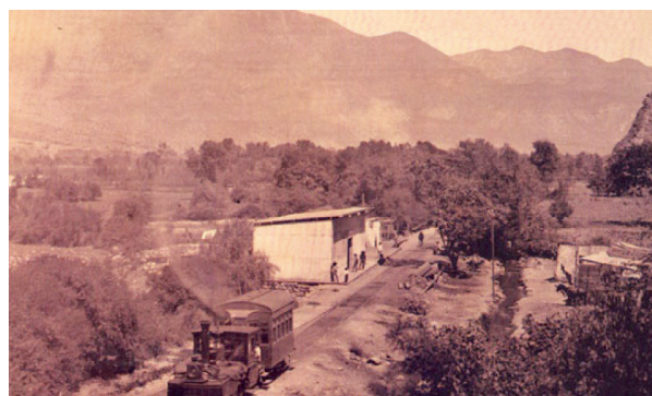
Figura N.º 7. Depósito de carbón La Galgada.
