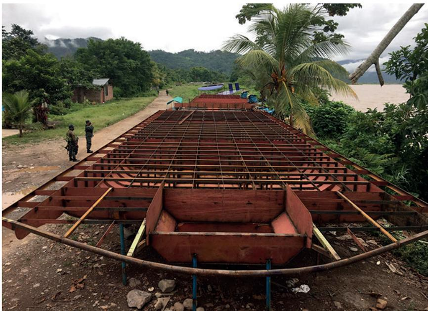
Figura 3. Diseño de construcción convencional tipo chimpa
