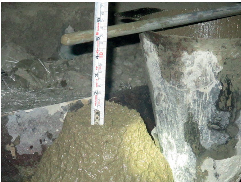
Figura 5. Control del revenimiento del concreto con relave.
