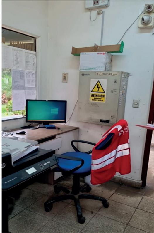
**Figura 6.** Riesgo eléctrico. Instalaciones eléctricas en ambientes inapropiados, equipos eléctricos mal ubicados, sobrecarga de líneas, interruptores inadecuados, tormenta de rayos, entre otros. Condiciones no apta para el uso del personal SUTRAN.
