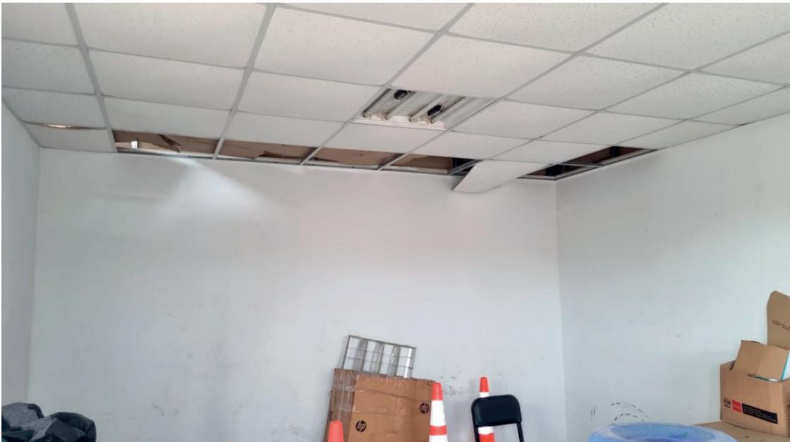
**Figura 7.** Riesgo locativo. Infraestructura y equipos en mal estado, caída de agua por goteras en el techo, falta de orden y limpieza. Condiciones no apta para el uso del ambiente por el personal SUTRAN.
