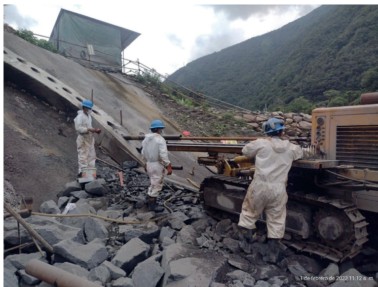
Figura 7. Sondeo geotécnico realizado en el hastial derecho
