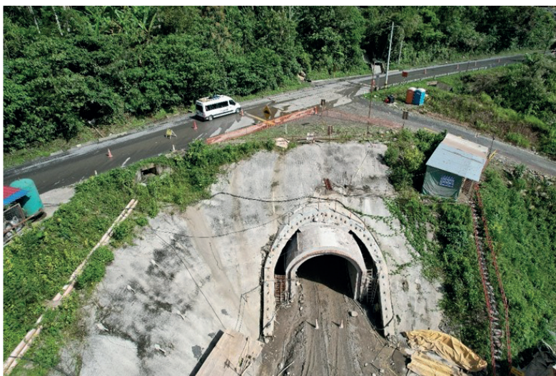
Figura 10. Vista aérea de la zona de trabajo
