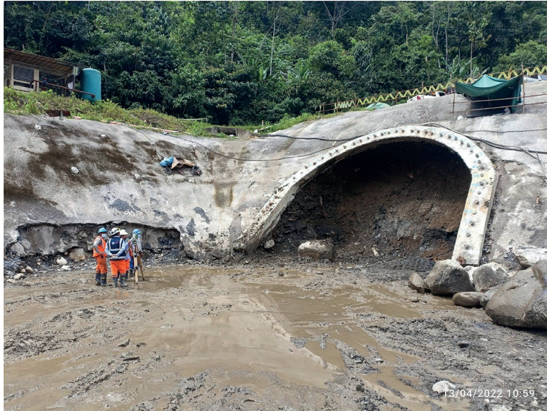
Figura 13. Instalación de micropilotes en el portal del túnel
