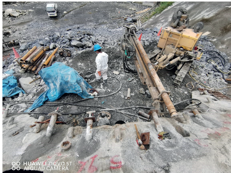
Figura 6. Sondeo geotécnico realizado en la zona de bóveda
