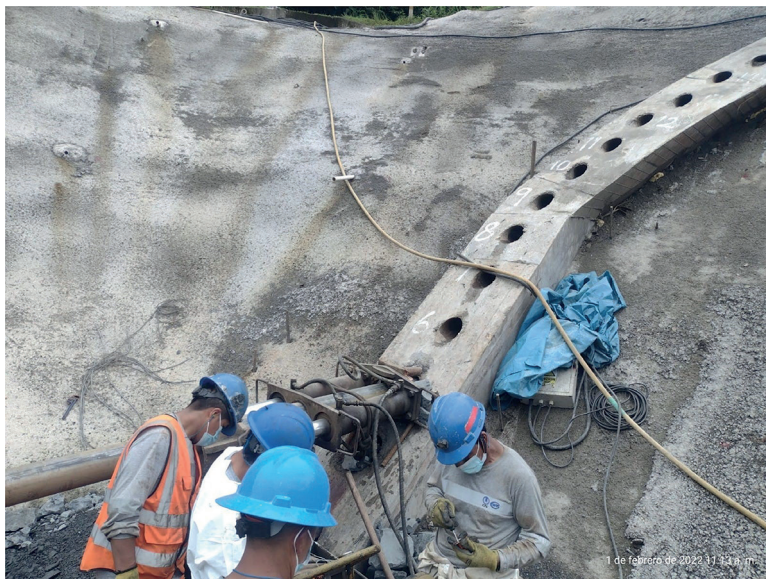
Figura 5. Sondeo geotécnico realizado en el hastial izquierdo
