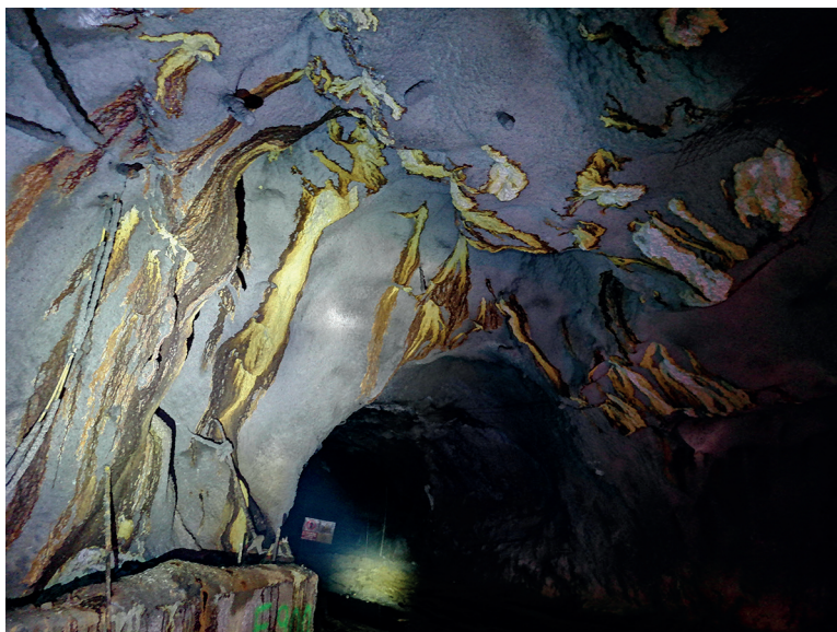
Figura 14. Labor minera subterránea con SRF de acero (excavación permanente)
