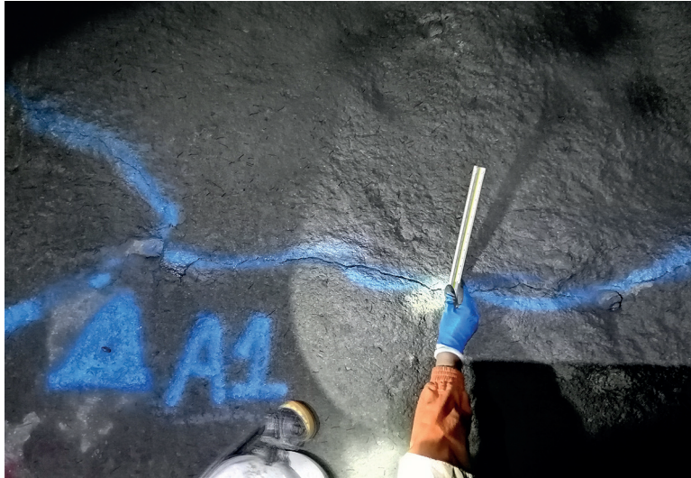
Figura 17. Medición del ancho de grietas en el SRF de acero Nota: Fotografía al personal realizando la medición del ancho de grieta en el SRF
