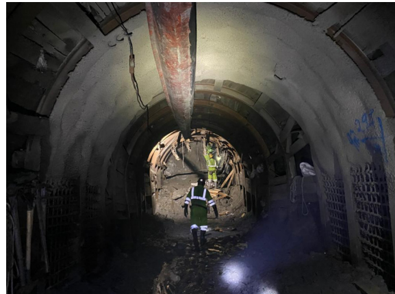
Figura 11 Arco peruano instalado en tajo de producción
