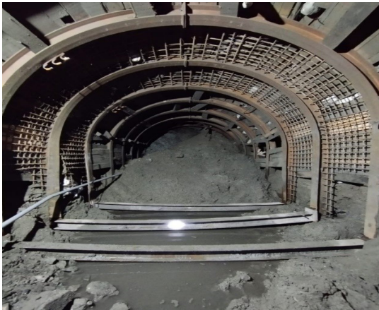
Figura 10 Instalación de la viga de acero del arco peruano en tajos de producción
