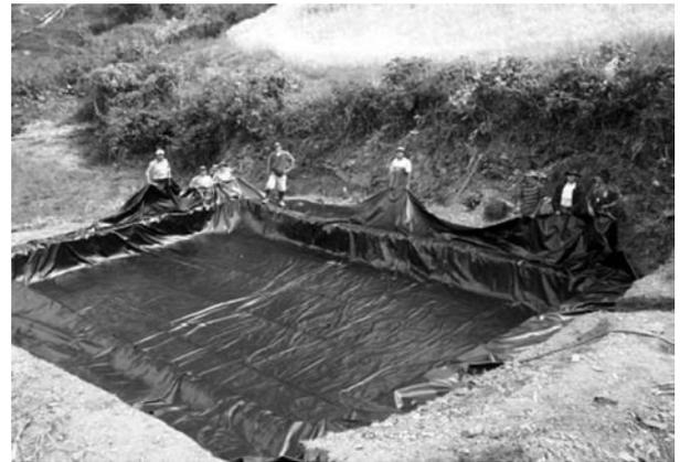
Foto 2. Tendido de la geomembrana.
