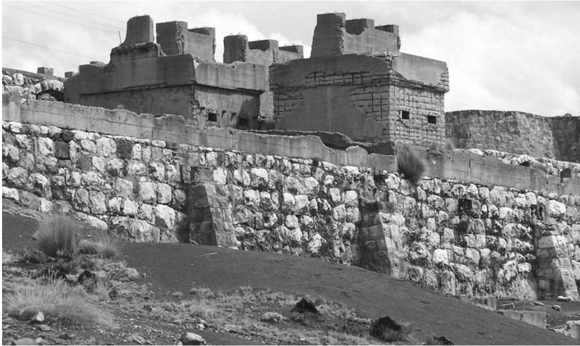
Foto 1. Restos de la Fundición de Tinyahuarco. Nótese la construcción pétreo y las estructuras de concreto.
