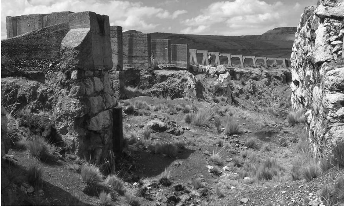
Foto 3. Vista de los hornos de la Fundición de Tinyahuarco.
