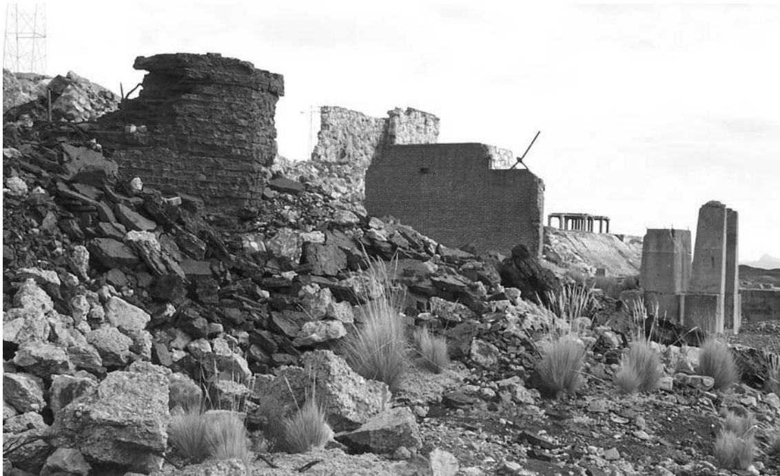
Foto 2. Parte destruida de la Fundición de Tinyahuarco.
