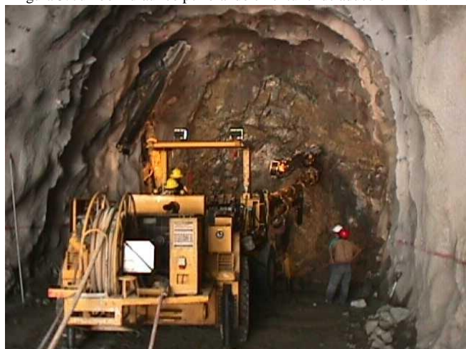
Figura 3: Jumbo hidráulico perforando en el túnel de aducción N° 4.
