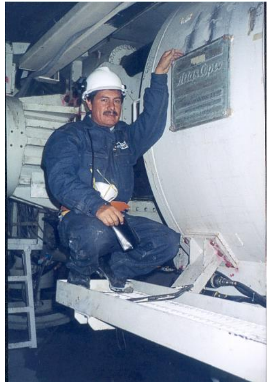
Figura 1 Unidad de accionamiento de la TBM MK 12
